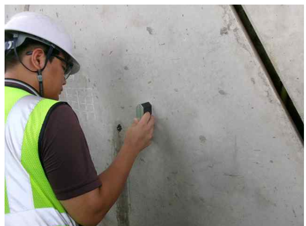
경사계를 이용한 경사도 측정
