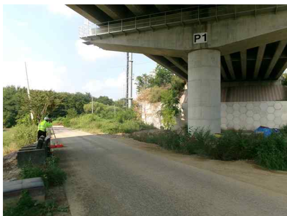
광파기를 이용한 측량 작업
